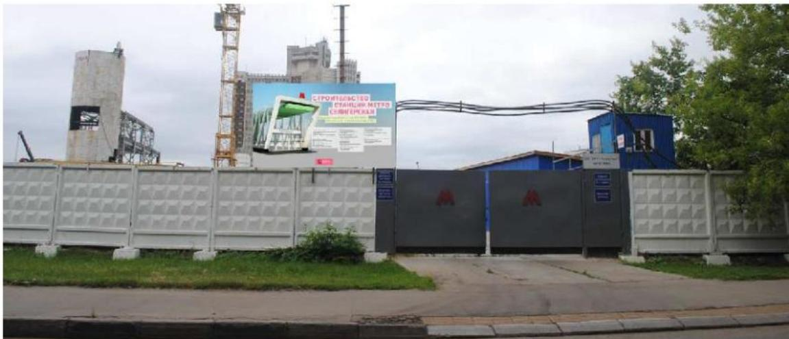
Паспорт-щит устанавливается при въезде на строительную площадку и выезде с нее. Паспорт-щит должен содержать следующую информацию:
